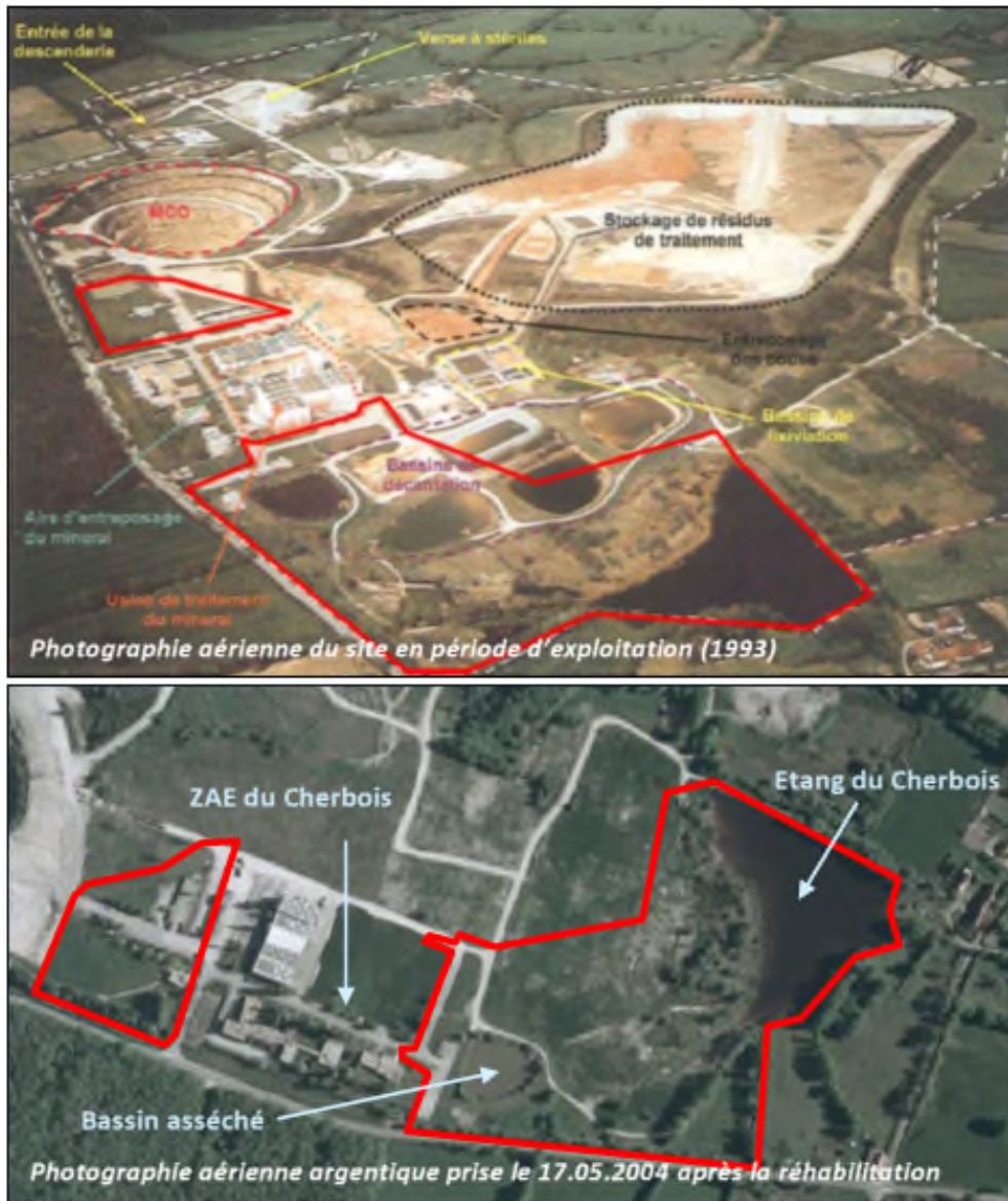
Figure 1 : zone d'implantation du projet au regard des anciennes activités minières
